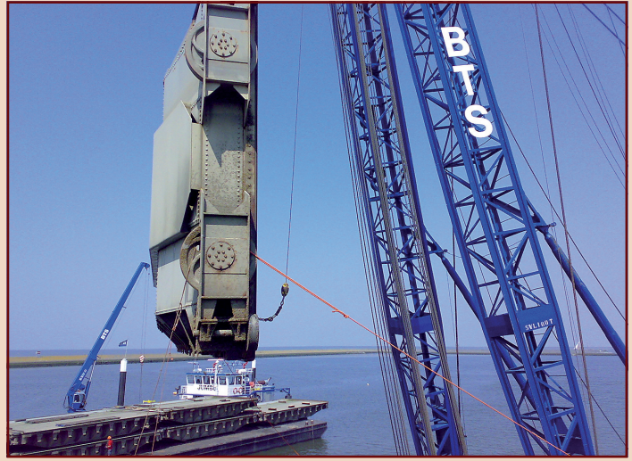
Transkeramisch Lunac 2+ aangebracht op bewegende delen afsluitdijkdeur van Kornwerderzand. De laag is hier toegepast vanwege de gelijktijdige weerstand tegen abrasieve (zand) slijtage, corrosie en de zekerheid van volledige hechting.
